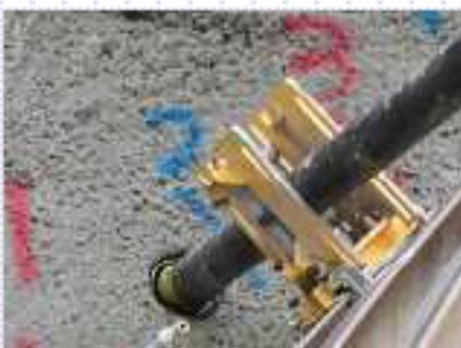
$\phi 139.8$ 鋼管を使用することにより、曲げ剛性を向上。また2重管仕様では、通常のAGF鋼管 ( $\phi 114.3$ ) の約3倍の曲げ剛性を確保しました。
