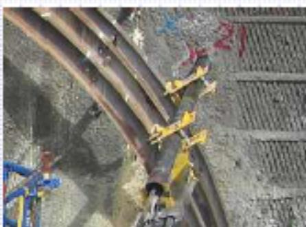
約40mの鋼管打設において、概ね1/200の高い打設精度の確保に成功しました。
