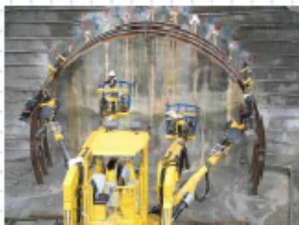
トンネル掘削で使用されるドリルジャンボを使用して $\phi 139.8$ 鋼管の超長尺打設が可能であり、専用の削孔機・人員を必要としません。
